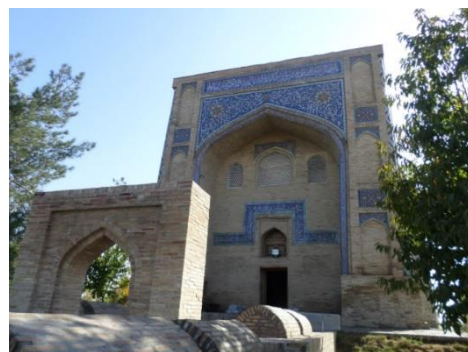
Западный и главный фасад мавзолея. Фото: М.Бекназаровой, 2022 г.
